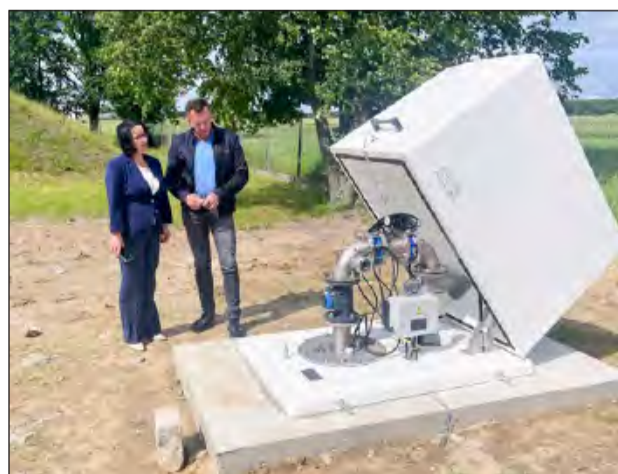
■ Na stacji uzdatniania wody w Nowym Goniwilku wykonano nowy odwiert studni głębinowej. 12 czerwca dokonano odbioru końcowego realizacji inwestycji „Przebudowa stacji uzdatniania wody na terenie gminy Żelechów”
