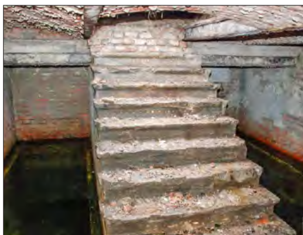
Fragment przyziemia budynku, stanowiący sklepienie pomieszczenia łaźni, znajduje się pomiędzy Pomnikiem Poległych i Pomordowanych a ulicą Pudły. Po podniesieniu żelaznej pokrywy widać basen dawnej mykwy i prowadzące do niego schody
