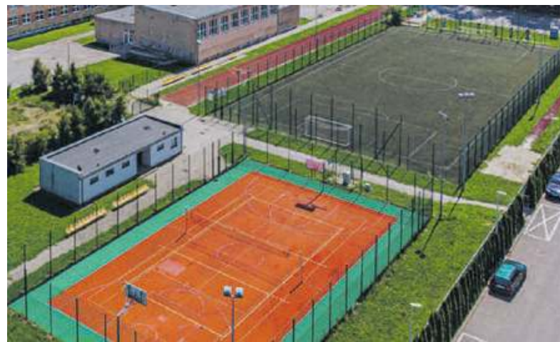
Orlik przy SLO przejdzie modernizację
