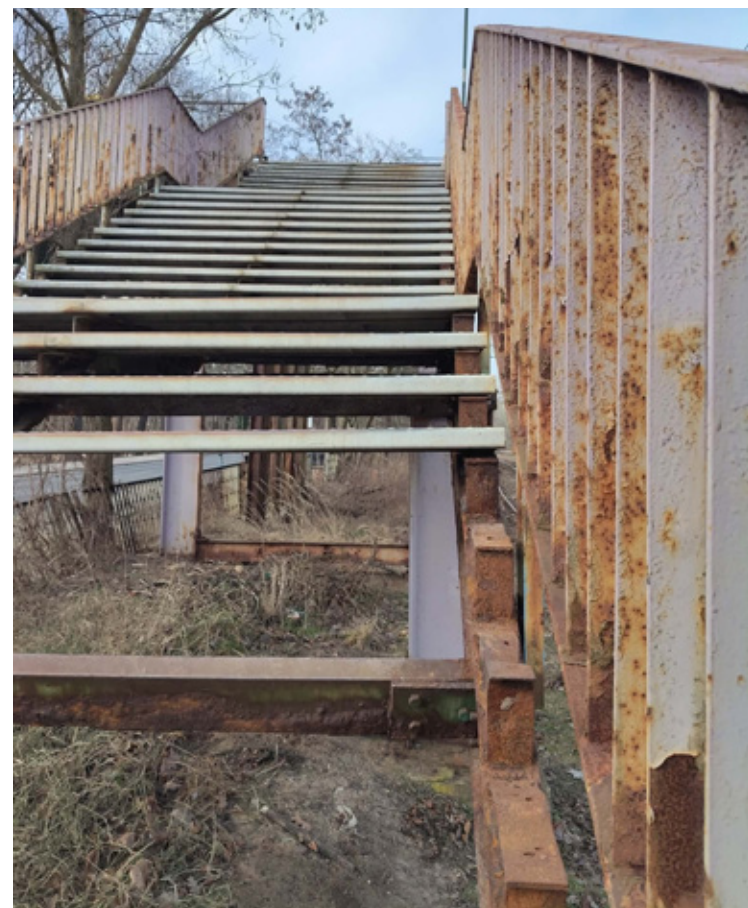
Kolejowa kładka nad torami PKP.
