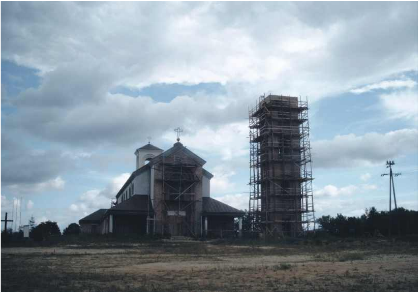
Budowa kościoła na Popławach w 2003 r.
