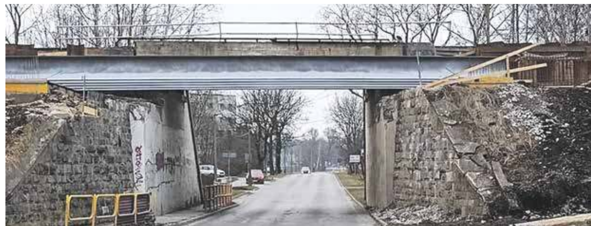
Wiadukt nad ulicą Sikorskiego zmienia wygląd
