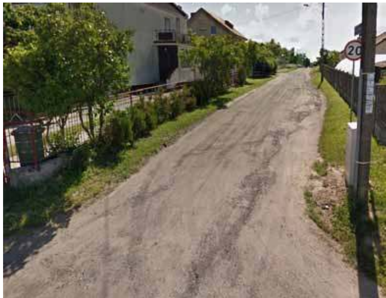
Od wielu lat mieszkańcy ul. Chełmońskiego czekają na budowę drogi oraz chodników. Foto archiwum
