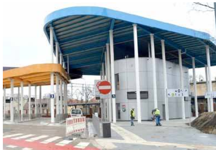
Jedną z ważniejszych inwestycji ostatnich lat była budowa Zintegrowanego Centrum Przesiadkowego
