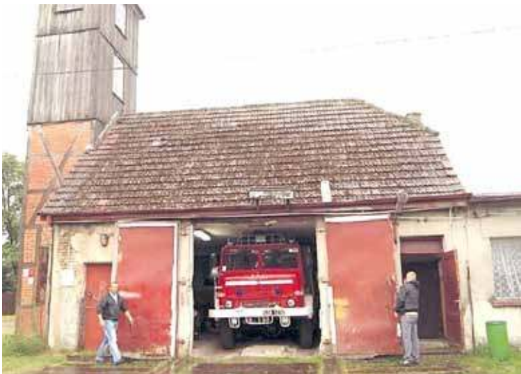
Strażacy z OSP Pęczino nie pracują w najlepszych warunkach o czym świadczy stan techniczny budynku remizy
