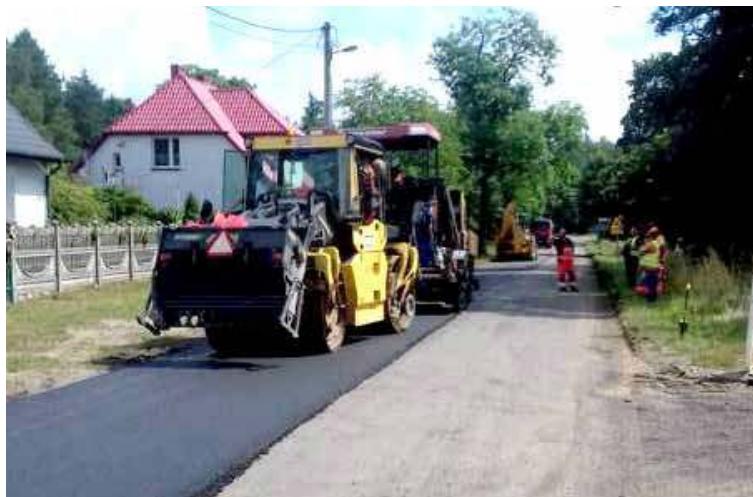
Prace związane z przebudową ulicy Stargardzkiej osiągnęły półmetek
