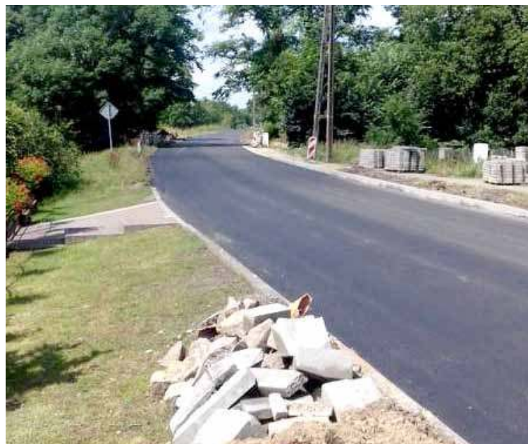
W ramach prac wykonano nowe krawężniki
