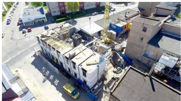
Trwają intensywne prace przy budowie Stargardzkiego Centrum Nauki.
