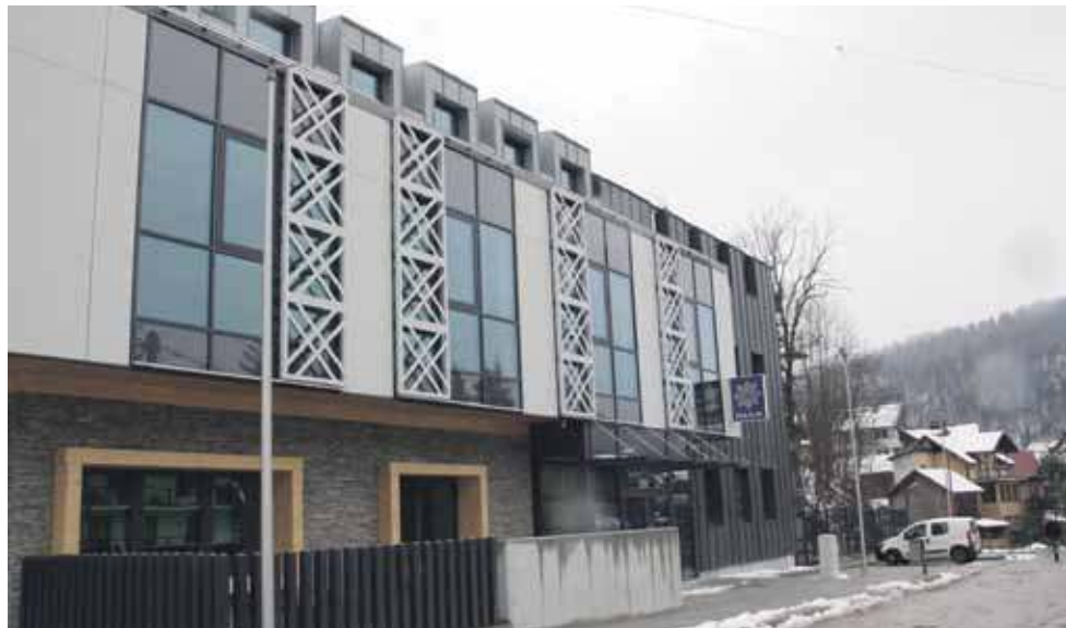
Aktualnie trwa odbiór budynku komisariatu w Szczawnicy.
