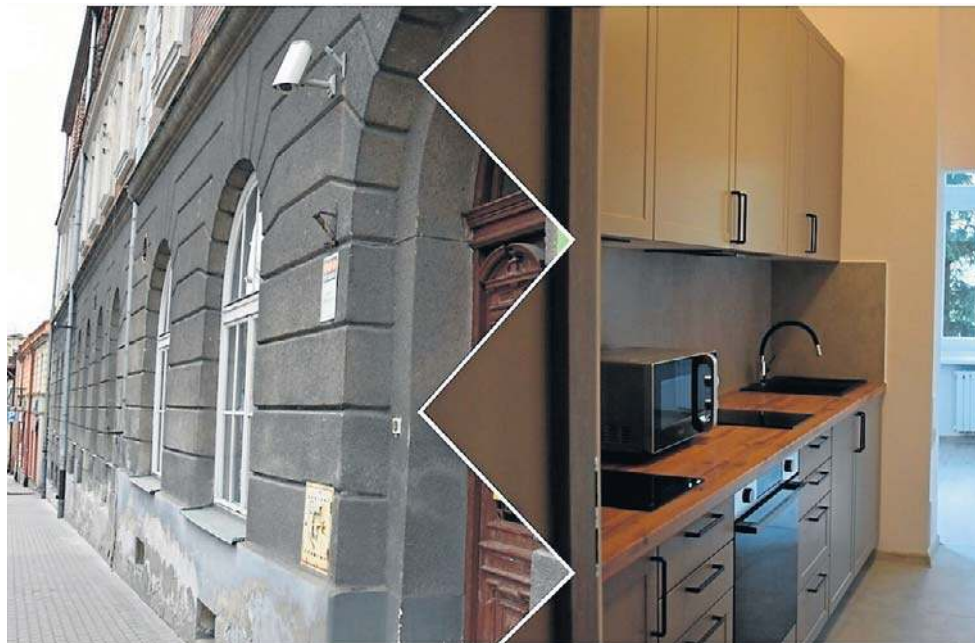
Bursa przeszła gruntowny remont, w ramach którego odnowiono jej wnętrza
