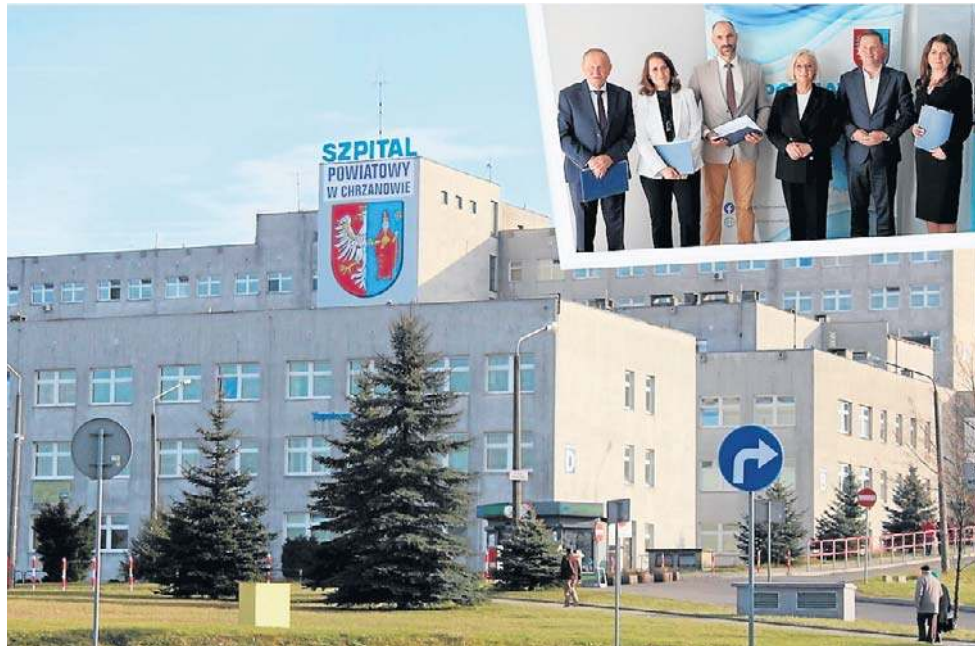
Podpisano umowę na rozbudowę Szpitala Powiatowego w Chrzanowie
