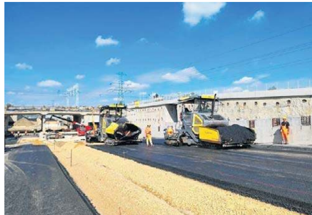
Do zakończenia budowy obwodnicy Oświęcimia pozostało dwa i pół miesiąca. Trwają końcowe prace
