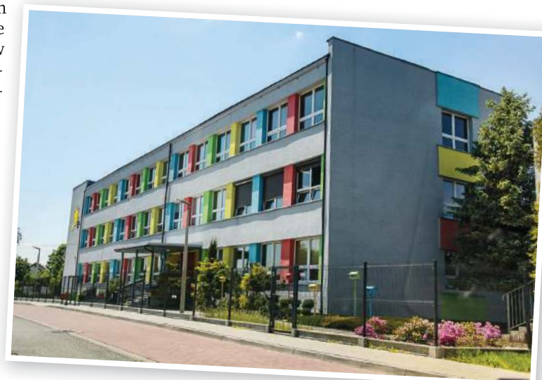
Budowa nowej windy ZPSWR okazuje się być sprawą nieprzesadzoną. Na przeszkodzie stanęły koszty inwestycji.
