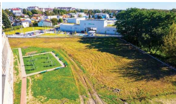
W tym miejscu powstanie nowy park
