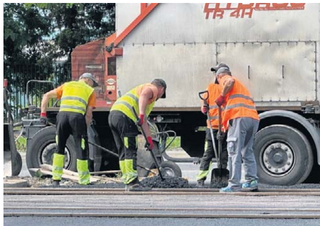
Ustalono, że remont będzie miał bardzo szczegółowy charakter i potrwa do jesieni 2027 roku
