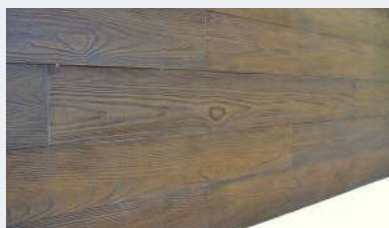
Elastyczna okładzina 3D realistycznie imituje deski elewacyjne ze stojami.
