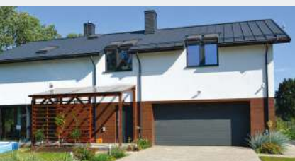
Elewacje wykończono tynkiem silikonowym i okładziną akrylową.
