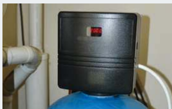
Głowica automatyczna ułatwia obsługę kolumny filtrującej.
