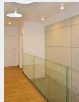
Ta sama żelbetowa przegroda na poddaszu.
