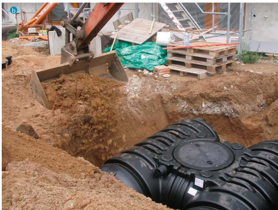
Zbiorniki podziemne – betonowy (a GIZO) i z tworzywa (b ROTH POLSKA).
