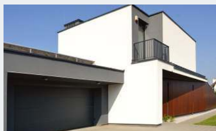
➊ Na fasadzie frontowej – tynk silikatowy i okładzina z modrzewia syberyjskiego.
