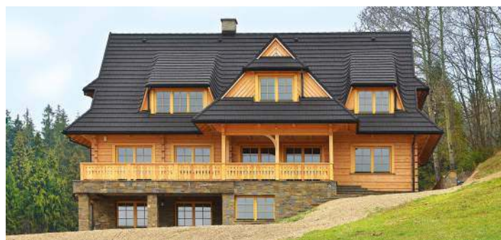
Blachodachówki z posypką wykończone są kruszywem skalnym lub barwionym piaskiem kwarcowym. Wyglądem przypominają łupek kamienny. AHI ROOFING
