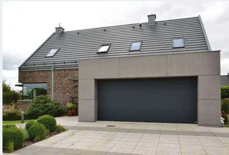
Szczeliny między płytami włókno-cementowymi dopasowano do układu segmentów płaszcza bramy garażowej.
