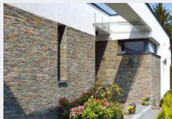
🔗 Faktura drobnych elementów okładziny tworzy na fasadzie efekt 3D.
