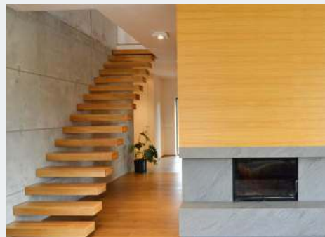
Ścianę wylano z betonu architektonicznego i zakotwiczone w niej wspornikowe stopnie.
