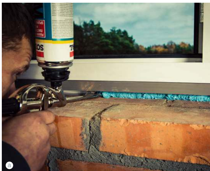
❶ Szczelinę między ramą i murem wypełniamy pianą montażową (a), którą później zabezpieczamy taśmami – paroszczelną od środka (b) i paroprzepuszczalną od zewnątrz. KAMPANIA EDUKACYJNA DOBRY MONTAŻ
