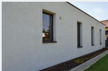
🔗 Elewacja północna została tylko otynkowana, właściciele zamierzają dodać na niej pasy okładziny.
