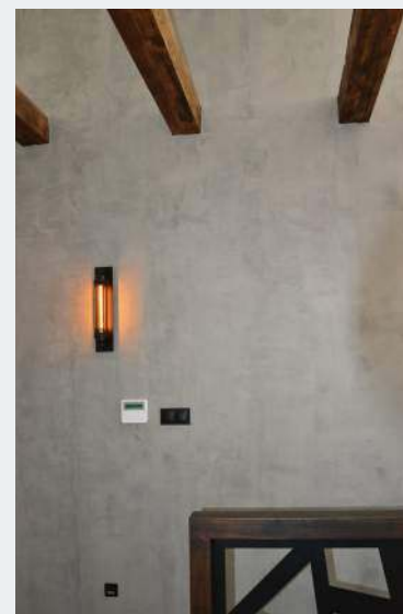
🔗 Na ścianie ułożono kolejno trzy warstwy – podkład, tynk dekoracyjny, powłokę zabezpieczającą.
