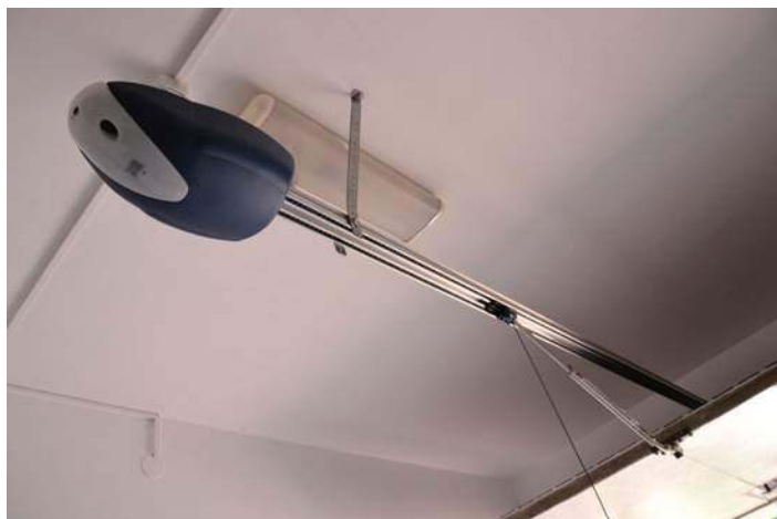
Siłowniki przeznaczone do skrzydeł otwieranych do góry (segmentowych i płytowych) montuje się pod sufitem. L. JAMPOLSKA, BENINCA
