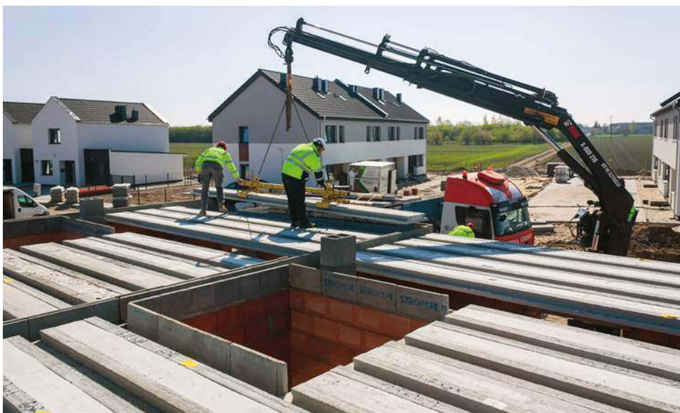
🔗 Stropy prefabrykowane można wykonać tam, gdzie na działkę da się wjechać ciężkim sprzętem. W przypadku konstrukcji panelowych wystarczy lekki dźwig typu HDS. STROPY.PL
