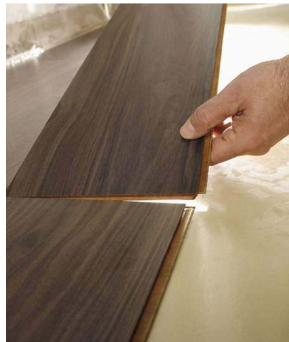
Najpopularniejszy sposób układania paneli polega na wsuwaniu kolejnych elementów w złączenia tych już ułożonych. WINEO
