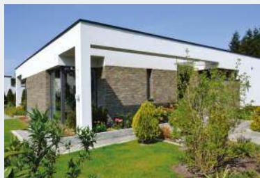
🔗 Elewacje wykończono białym tynkiem silikonowym i okładziną z łupka.
