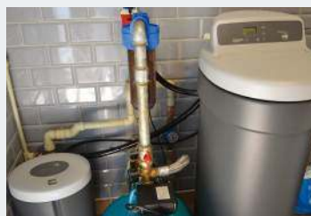
Od lewej – filtr z węglem aktywnym, mały filtr mechaniczny, zmiękczacz.
