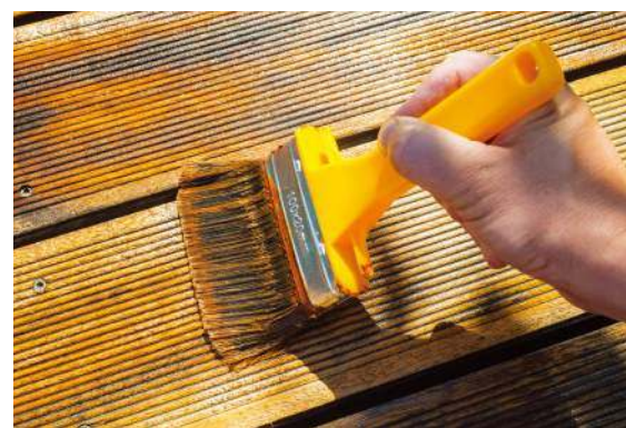
Przed każdym letnim sezonem, deski należy wyczyścić szczotką, myjką ciśnieniową (a) i ponownie zabezpieczyć olejem (b). JAF POLSKA
