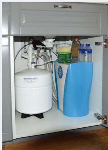
Stacja odwróconej osmozy w szafce pod zlewozmywakiem.
