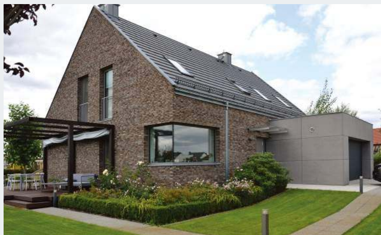
Fasadę wzniesiono z cegły klinkierowej i płyt włókno-cementowych.
