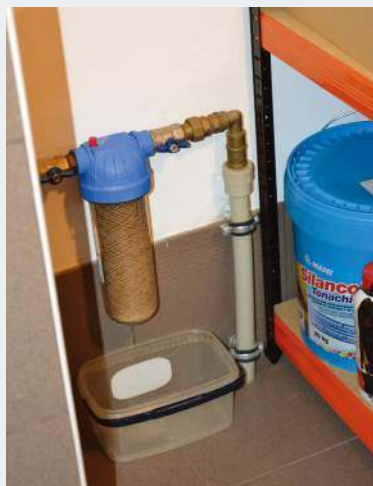
Za wodomierzem zamontowano wymienny filtr mechaniczny (sznurkowy).
