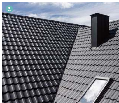
Blachodachówka z przetłoczeniami imitującymi tradycyjną dachówkę (a BLACHPROFIL 2) i płaską (b BLACHY PRUSZYŃSKI).
