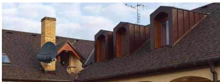
Gonty mogą być układane na dachach o nachyleniu połaci od 12 do 90°. IKO
