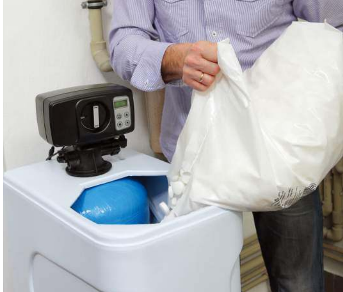
➊ Zmiękczacze wyposażone są w zbiornik na sól np. o pojemności 25 kg. USTM
