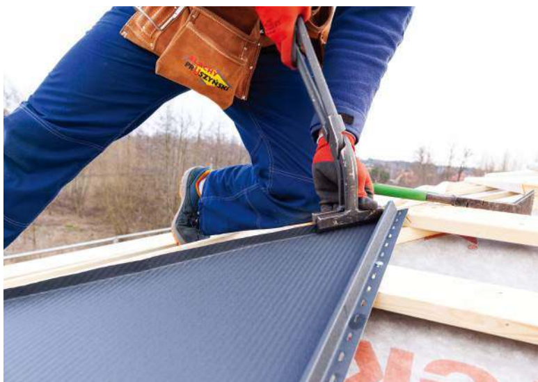
🔗 Montaż pokrycia z blachy płaskiej na dachu spadzistym. BLACHY PRUSZYŃSKI
