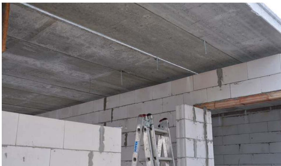
Schemat stropu panelowego.
