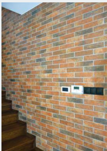
🔗 Płytki przyczepiono i zafugowano specjalnymi zaprawami do klinkieru (bez impregnowania).
