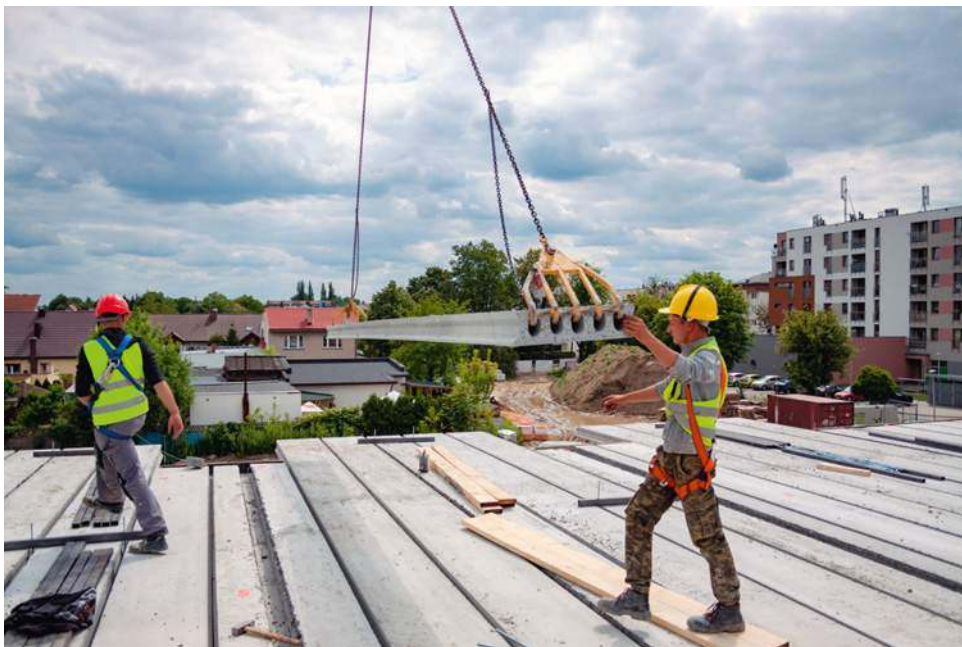
🔗 Montaż stropów panelowych jest bardzo szybki – ułożenie 100 m 2 zajmuje zaledwie 2 godziny. STROPY.PL
