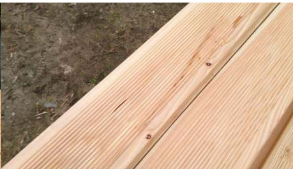
Na taras najczęściej stosuje się deski ryflowane, które są mniej śliskie po deszczu. T. RYBARCZYK
