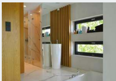
Ściany wokół wanny wykończono farbą-masą imitującą beton (efekt nieudany), dalej fornirowane lamele i wielkie lustro.
