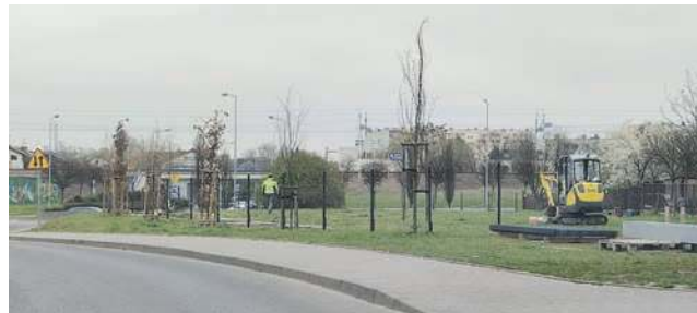
Budowa psiego parku przy ul. Mieszka I w Chrzanowie
