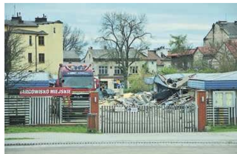
Rozbiórka Targowiska Miejskiego przy Kusocińskiego w Chrzanowie
