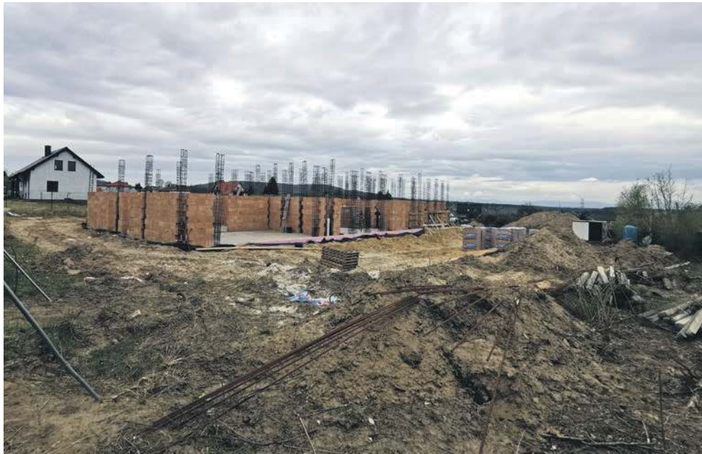
Trwa budowa nowego ośrodka zdrowia w Zagórze
