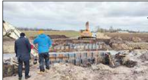
Władze powiatu i zarządu dróg powiatowych skontrolowali postęp prac przy przebudowie mostu w Lisiwólce
