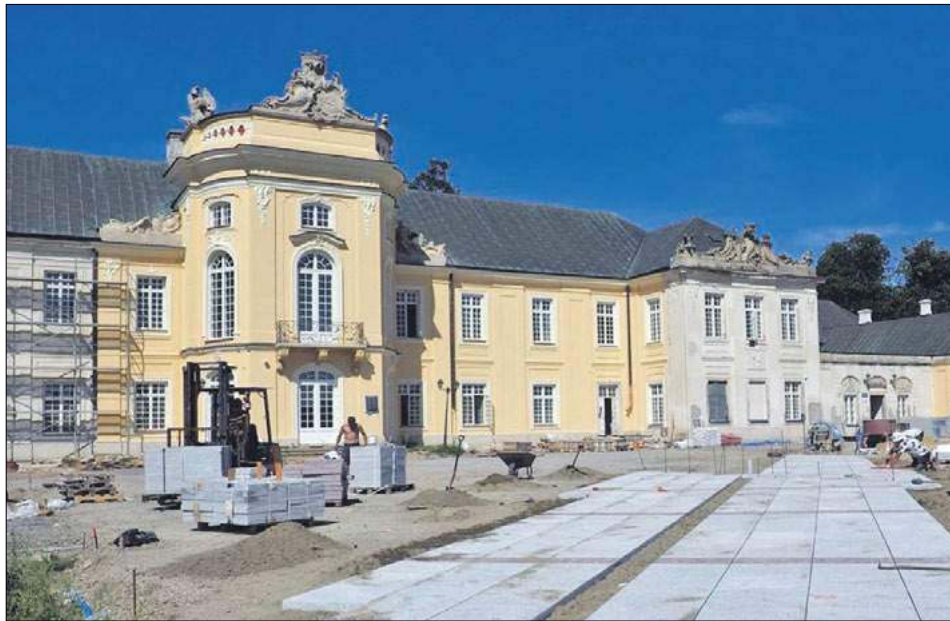
Wykonawca rewitalizacji pałacu Potockich miał ją wykonać za 18,9 mln zł. Zawnioskował o waloryzację kwoty i otrzyma 1,5 mln zł więcej
