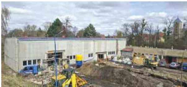
Trwają prace związane z przebudową stacji uzdatniania wody w Wiązowie. Fot. UMiG Wiązów
