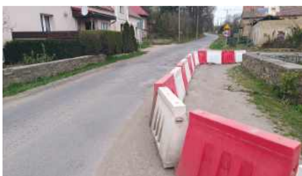
Powiat Strzeliński już niedługo zrealizuje remont mostu w Cierpicach w gminie Przeworno
