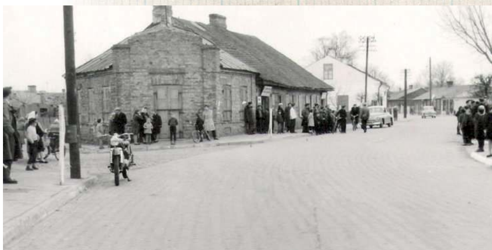
Dom na rogu Stodolnej i Piłsudskiego należał do cadyka Morgensterna. Nie był to jednak jedyny budynek należący do kompleksu „Dworu”
