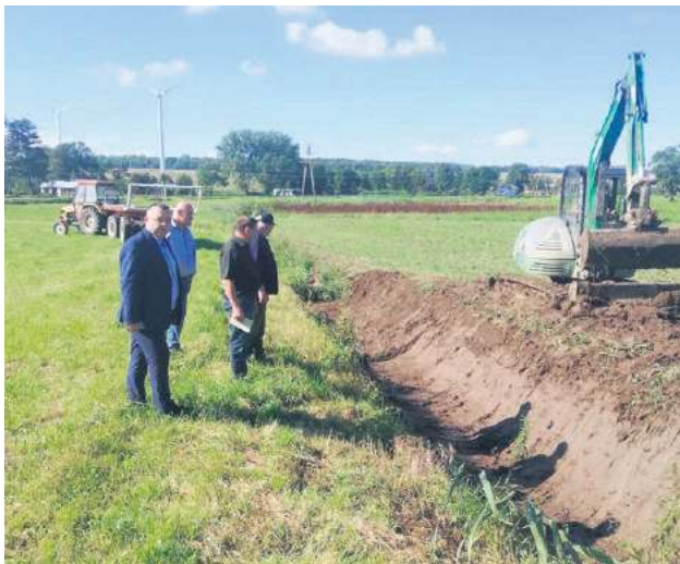
W Nedeżowie prace już zakończono, teraz ekipa przeniosła się do Gródka-Kolonii.
