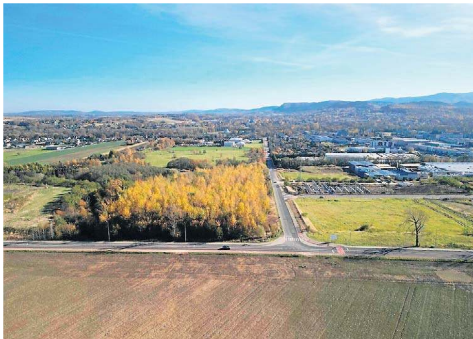
Trwają przygotowania do budowy Beskidzkiej Drogi Integracyjnej
