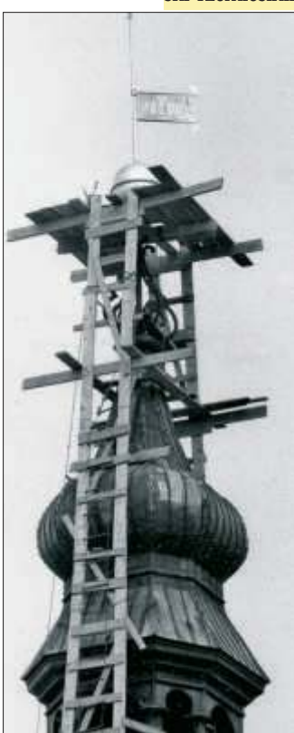
Przy montowaniu chorągiewki nie użyto dźwigów specjalistycznych ani podnośników.
