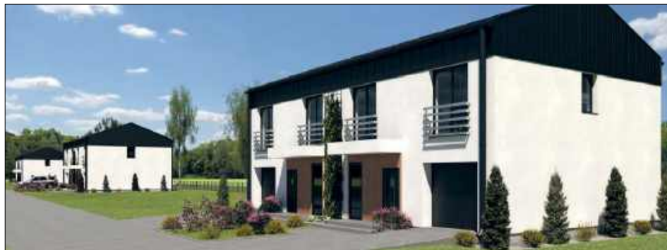
GreenWin rozpoczyna budowę nowoczesnych bliźniaków
