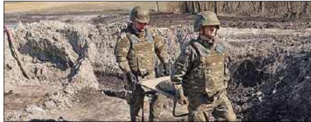
Do zdarzenia doszło na terenie gm. Zalesie podczas prac przy hydrobudowie
