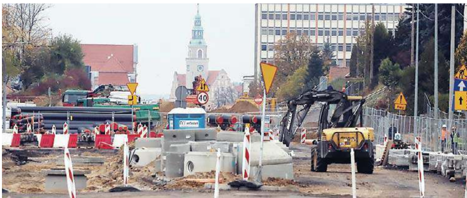
Prace przy budowie linii tramwajowej na al. Piłsudskiego w Olsztynie
