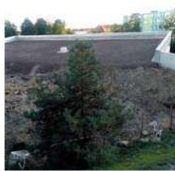
Dach pokryty ziemią
