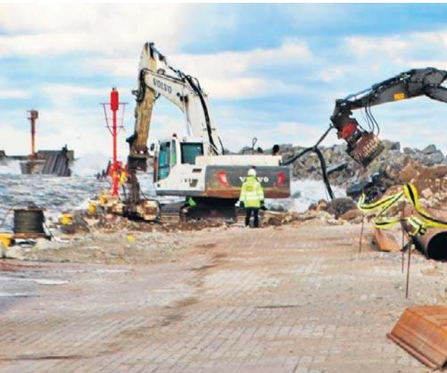
Roboty przy rozbiórce Falochronu Wschodniego w porcie w Ustce
