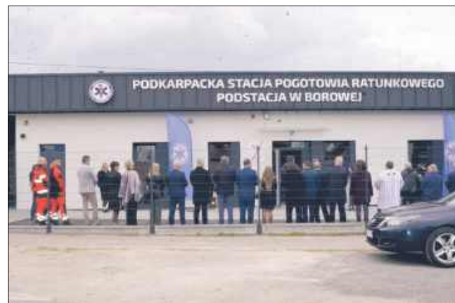
Budynek podstacji pogotowia w Borowej.
