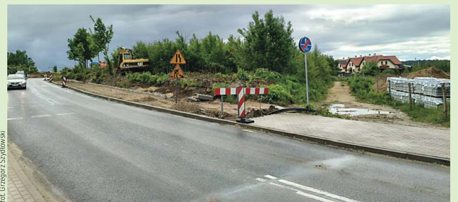
Budowa ścieżki rowerowej z Zacisza do Bartąga
