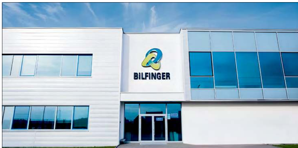
Siedziba firmy w Krapkowicach.
