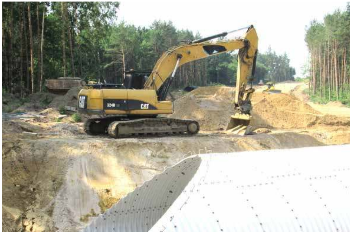
Już widać trasę obwodnicy w lesie
