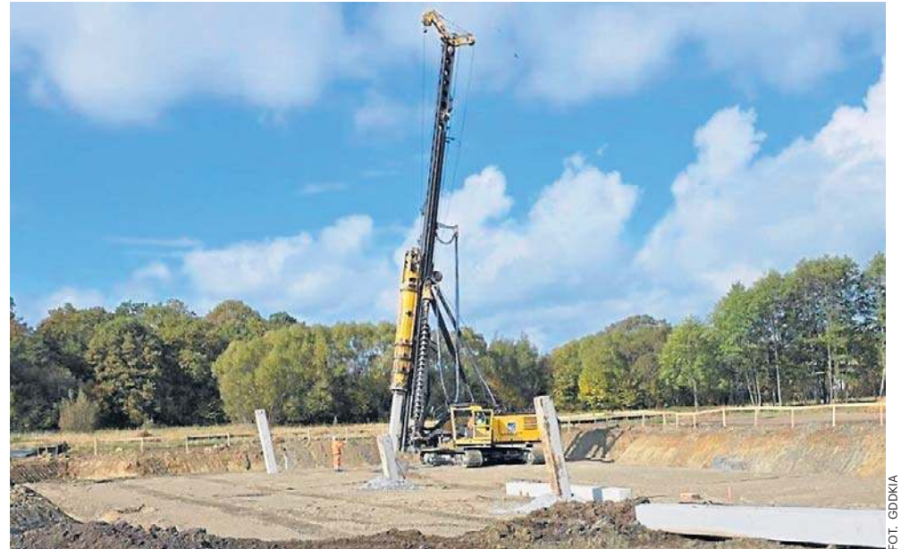
Pierwsze prace palowe na odcinku S19 Domaradz - Iskrzynia (Krosno)
