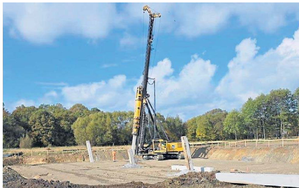
Pierwsze prace palowe na odcinku S19 Domaradz - Iskrzynia (Krosno)
