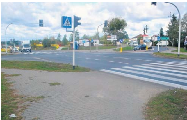
Po przeniesieniu kładki dla pieszych w Lubiczu Dolnym na zachodnią stronę, budynek trzeba będzie rozebrać
