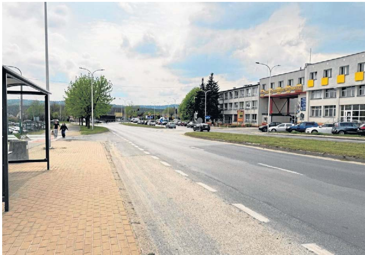
W środę, 29 lipca, rozpocznie się remont ulicy Jagiellońskiej w Kielcach na odcinku od Kołłątaja do Krakowskiej. Najpierw remontowana będzie zachodnia strona ulicy
