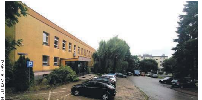
W dawnej SP 1 przy Borelowskiego ma się mieścić szkoła muzyczna, ale dopiero po przeprowadzonych remontach
