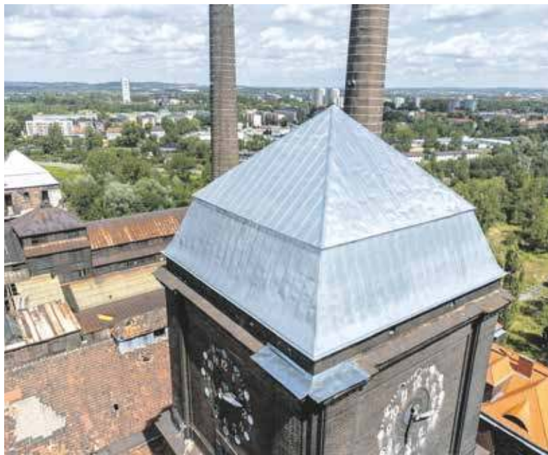
Nowy blask wyremontowanego dachu wieży wodno-zegarowej EC Szombierki
