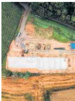
Plac budowy mieszkań na terenie Trzciany
