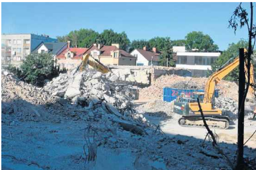
Między ulicami Garbarską i Ochronek od kilku tygodni trwa wielkie wyburzanie
