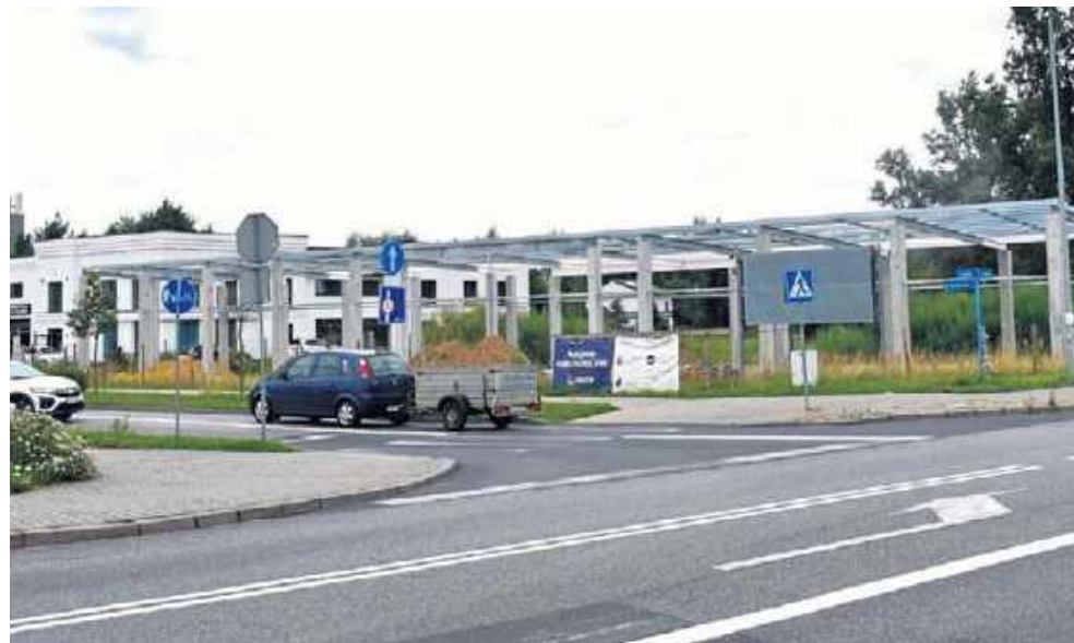
Inwestycja zaczęła się w listopadzie ub. roku. Stała konstrukcja i prace wstrzymano
