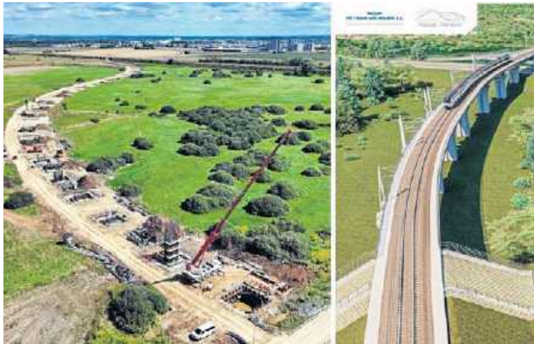
Tak powstaje nowa estakada kolejowa pod Krakowem
