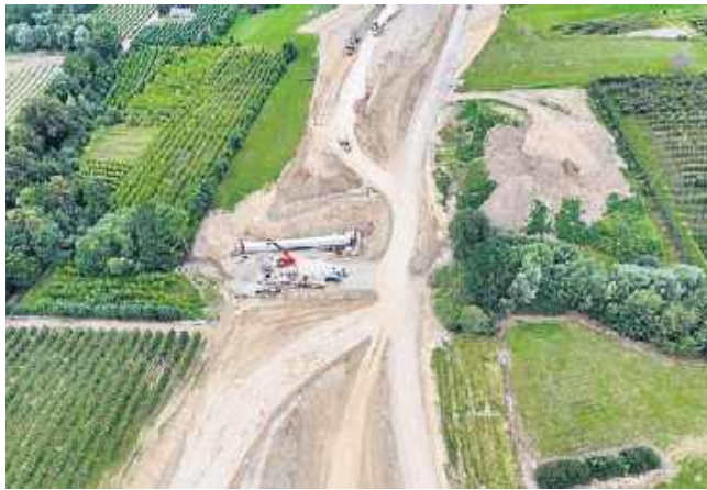
W rejonie Stróży i Wielkowiska trwają prace związane z przygotowaniem terenu do wiercenia tuneli kolejowych
