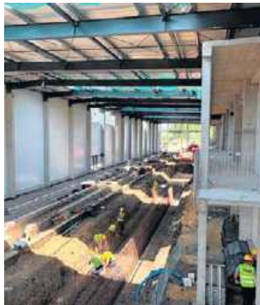
Budowa centrum serwisowego, postępuje bardzo szybko
