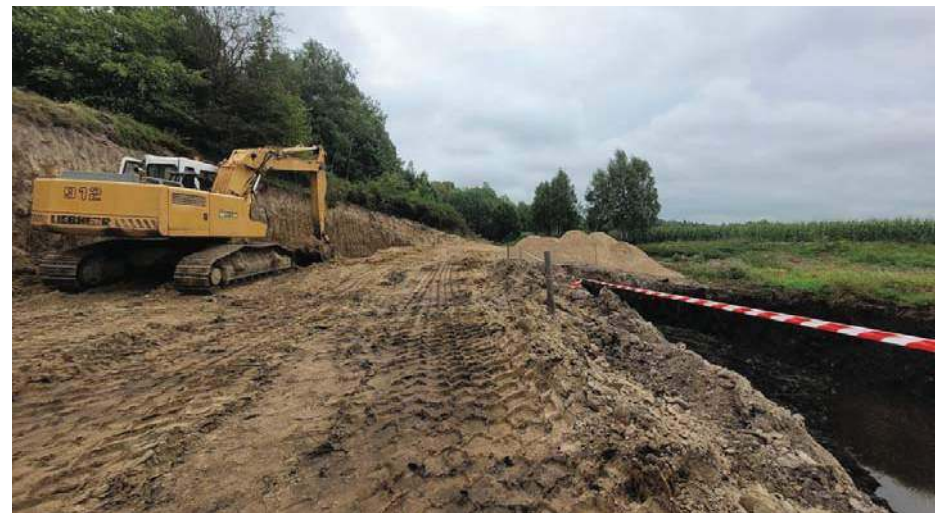
Aktualnie trwają prace przy II etapie, który obejmuje budowę „Pawilonu zdrowia”
