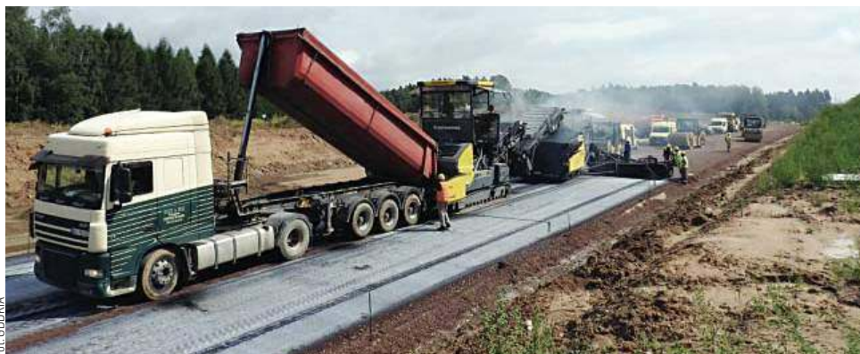
5,3-kilometrowy odcinek S5 Ornowo-Wirwajdy ma być oddany do użytku w maju 2023 roku, ale prawdopodobnie będzie to szybciej
