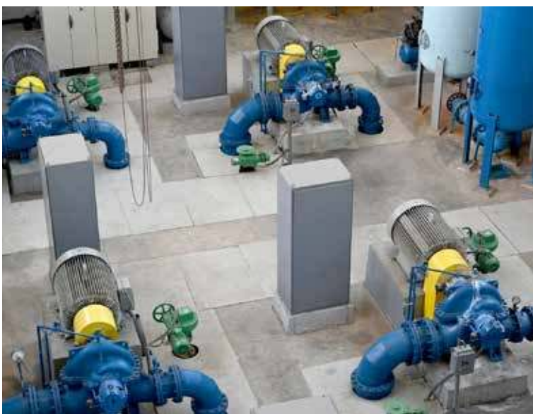
Zostanie przebudowany cały układ technologiczny uzdatniania wody
