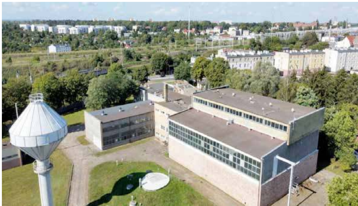
(red) Stacja uzdatniania wody zostanie poddana modernizacji
