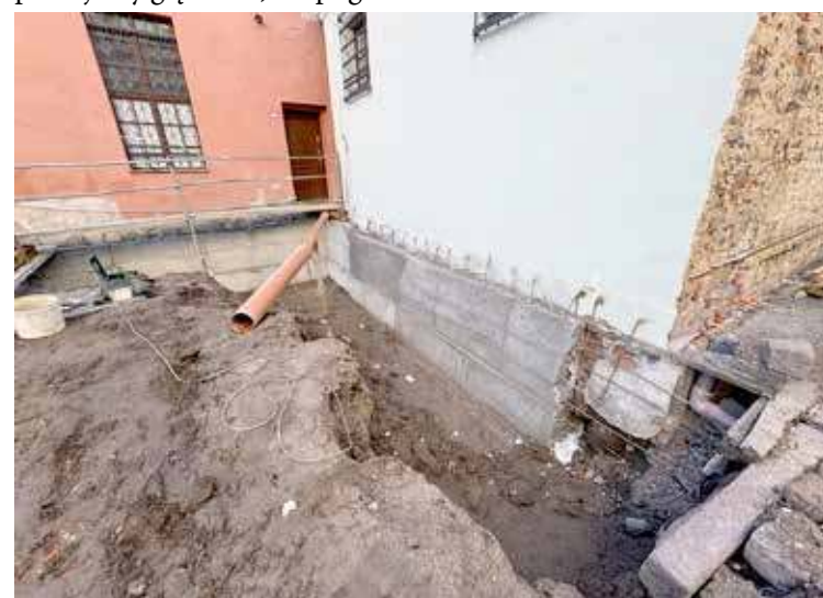
Trwa izolacja fundamentów przy budynku MAH
