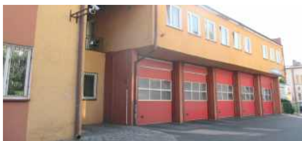
Centrum Aktywności Senioralnej znajdzie się w budynku po byłej komendzie PSP
