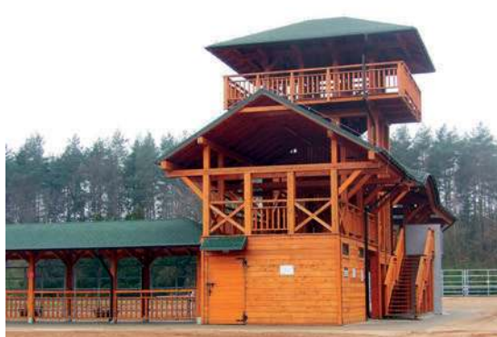
Taras i wieża widokowa
