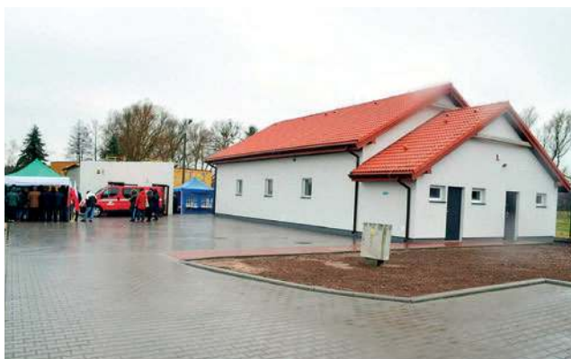
Na potrzeby przebudowy stacji uzdatniania wody, postawiono nowy budynek
