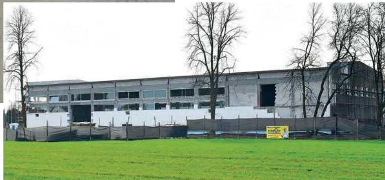
Hala sportowa w budowie
