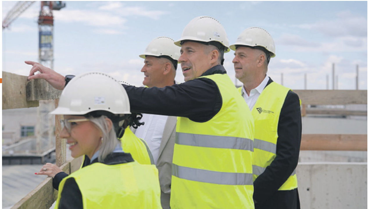
Marszałek Paweł Gancarz podkreśla, że Nowy Szpital Onkologiczny to największa inwestycja w zdrowie Dolnoślązaków. Tempo prac na budowie jest bardzo dynamiczne.
