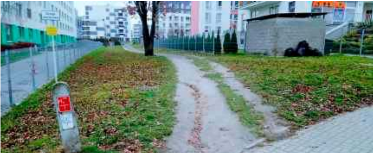
Budowa ścieżki ruszy lada dzień
