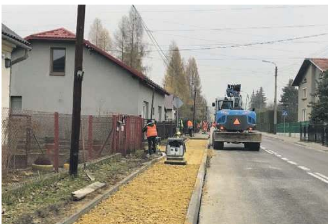
Rozpoczęła się wymiana chodników na ulicy Słowackiego
