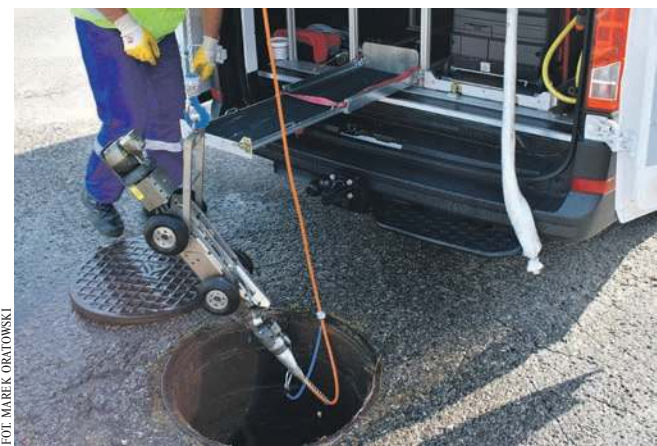
Pojazd wyposażony jest m.in. w dwie kamery jezdne
