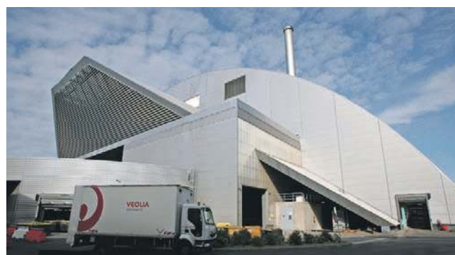
Zakład Odzysku Energii w Saint-Ouen-l'Aumône we Francji
