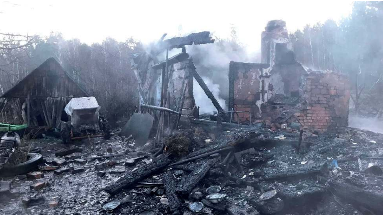
Mimo szybkiej reakcji straży dom mieszkańca Łysej Góry uległ całkowitemu spaleniu. Dodatkowym zagrożeniem była znajdująca się w budynku butla gazowa
