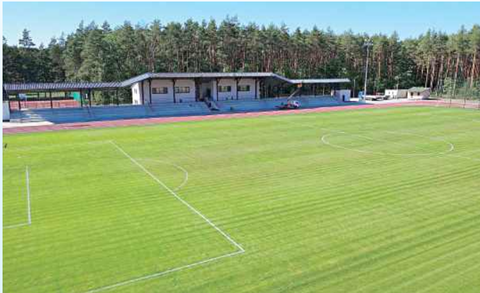
Zgodnie z planem stadion w Zwierzyńcu ma być gotowy do połowy października
