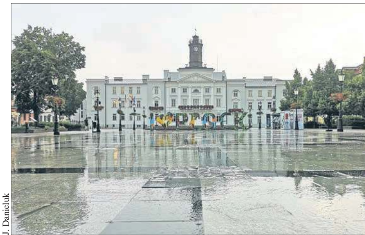
Budynek Urzędu Miasta w Płocku
