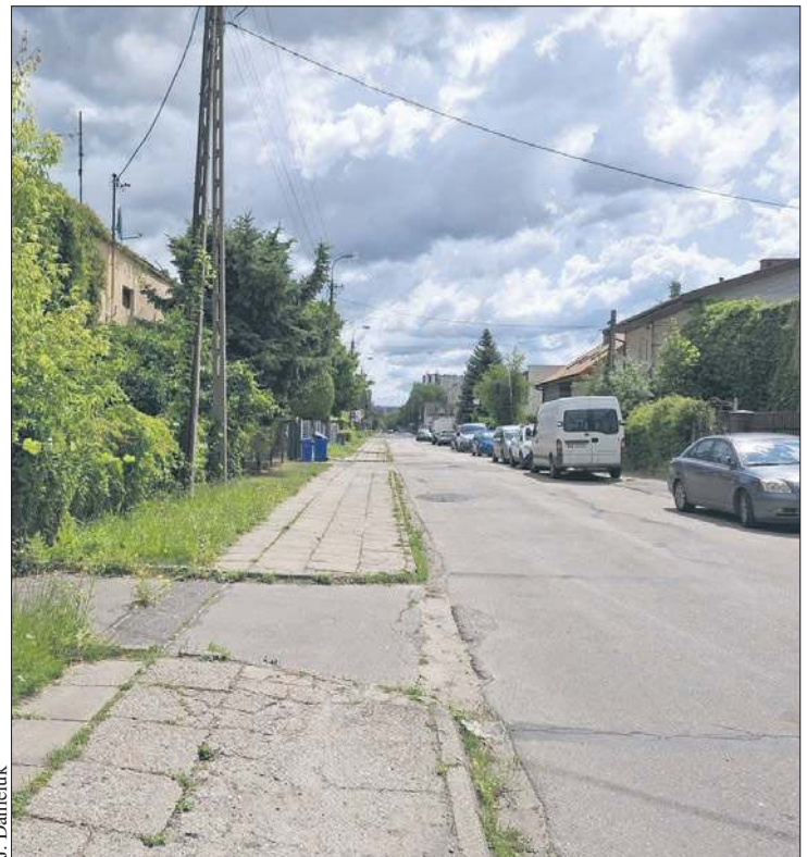
Część ulicy Lasockiego wymaga remontu
