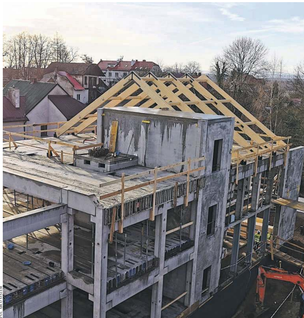
Tak obecnie wygląda budowane Muzeum Pożarnictwa przy Korycińskiego w Alwerni
