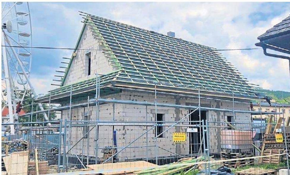
W ostatnim czasie wykonano zasadnicze prace konstrukcyjne, izolacje i prace dachowe
