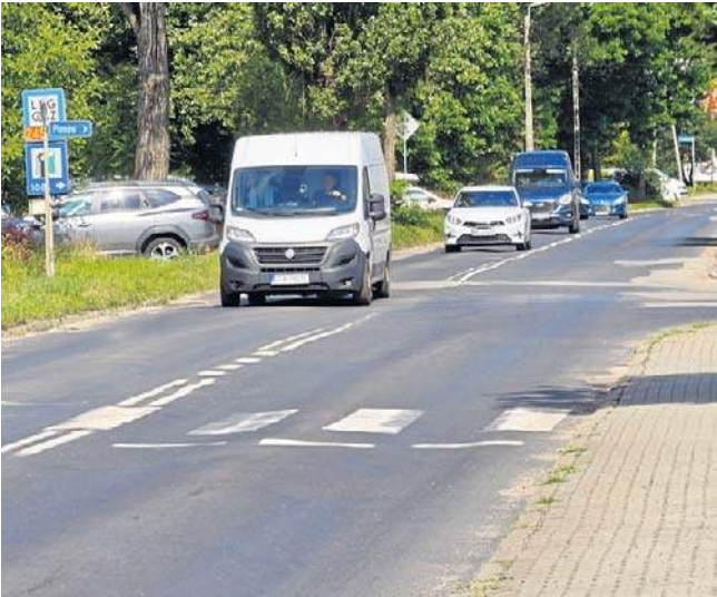
Tak wygląda obecnie odcinek ul. Grota-Roweckiego w Sosnowcu, od skrzyżowania z S86 do granicy z Czeladzią. Droga od lat domagała się remontu
