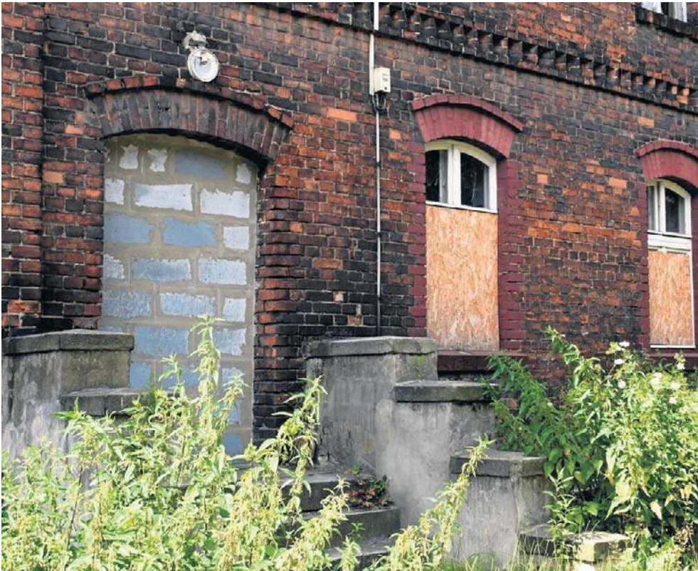
Opuszczone mieszkania w familoku przy ulicy Przemysłowej.
