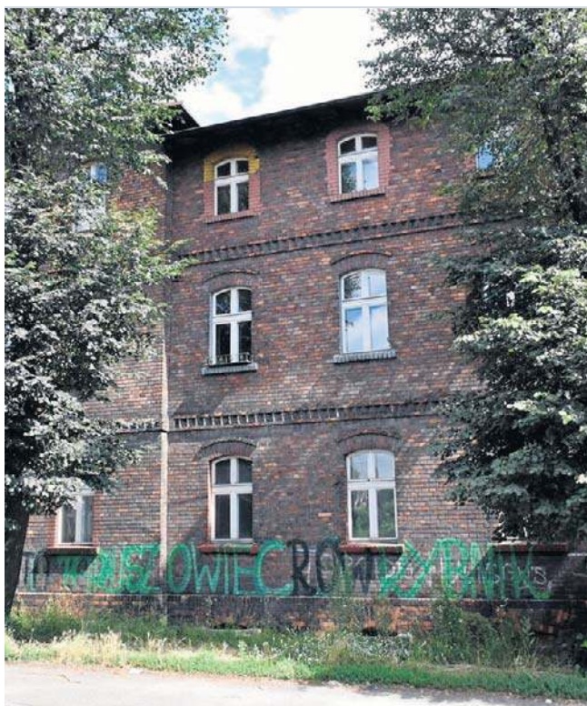
Budynki przy ulicy Przemysłowej, poza jednym już zrewitalizowanym, czekają na generalny remont.
