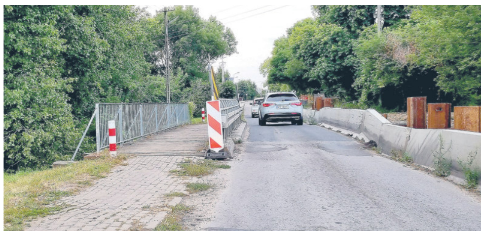
Przeciąga się remont drogi Siedlce - Łosice.
