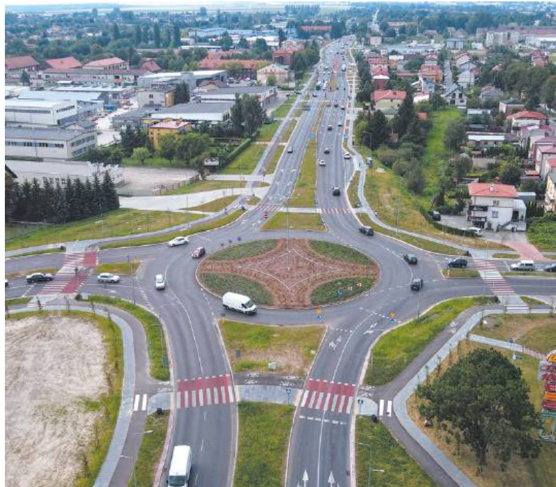
Rondo ul. Dzieci Zamojszczyzny, ul. Szczepieska, ul. Ślaska
