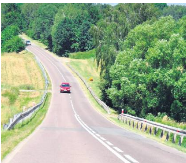
Droga zostanie rozbudowana na odcinku ok. 8,7 km, a na ok. 1,6 km – wyremontowana.
