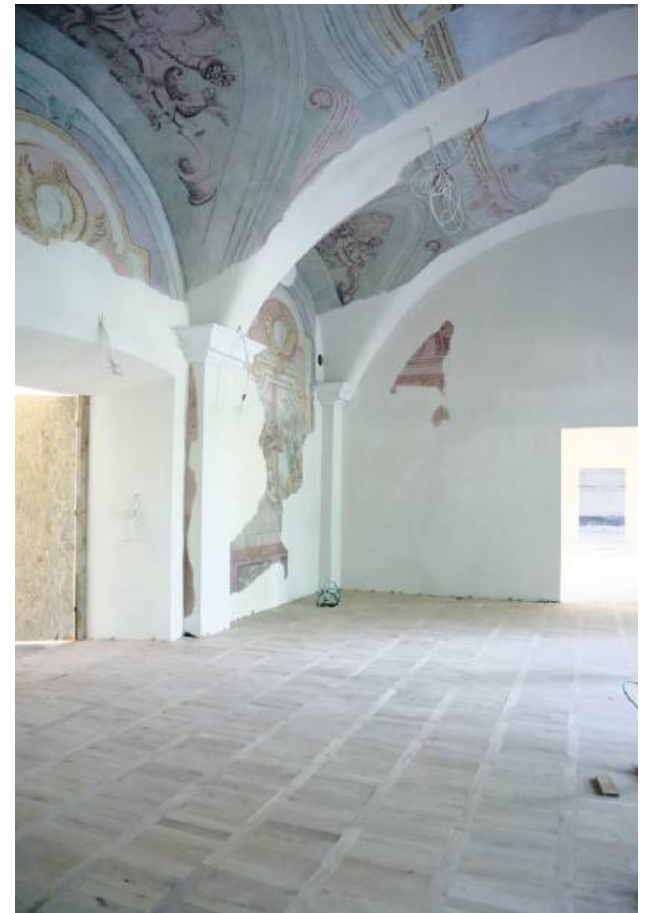
Pomieszczenie na parterze przeznaczone na sale muzealne.
