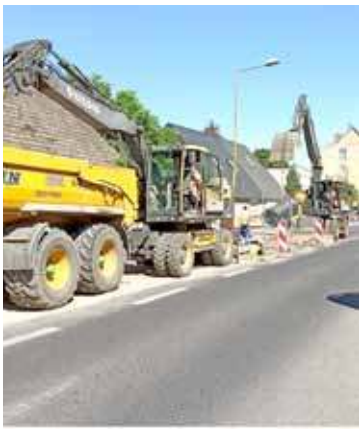
Trwa budowa kanalizacji, która będzie odprowadzała deszczówkę do rzeki Iny
